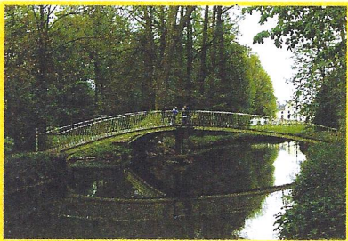
Pont à trois branches
